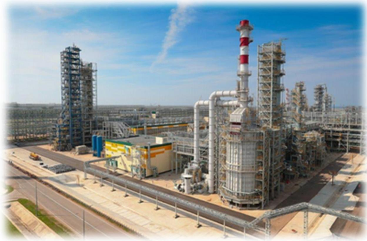
«Установка гидроочистки средних дистиллятов производительностью 3700 тыс. т/год по сырью Комплекса нефтеперерабатывающих и нефтехимических заводов»
